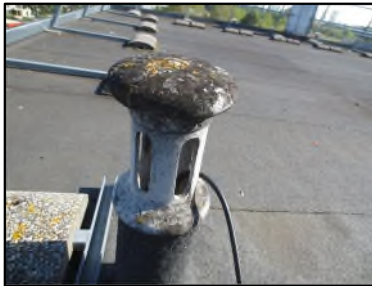
Photo N° 666 AMIANTE CIMENT -- Toiture terrasse Toiture Chapeau (Fibres-ciment)
