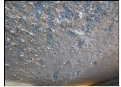
Photo N° 663 ECH-N°1 FLOCAGE -- LOCAL POUBELLE Plafonds blanc cotonneux
